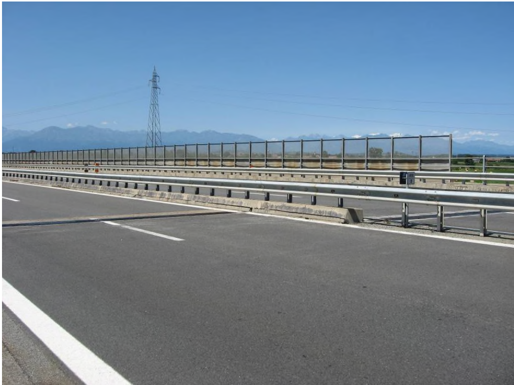
Barriera spartitraffico esistente su viadotto SP89 Torrazza – carreggiata sud
