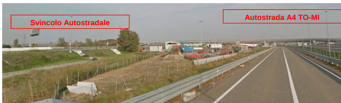
Lotto Nord, piazzale interno allo svincolo di casello.
