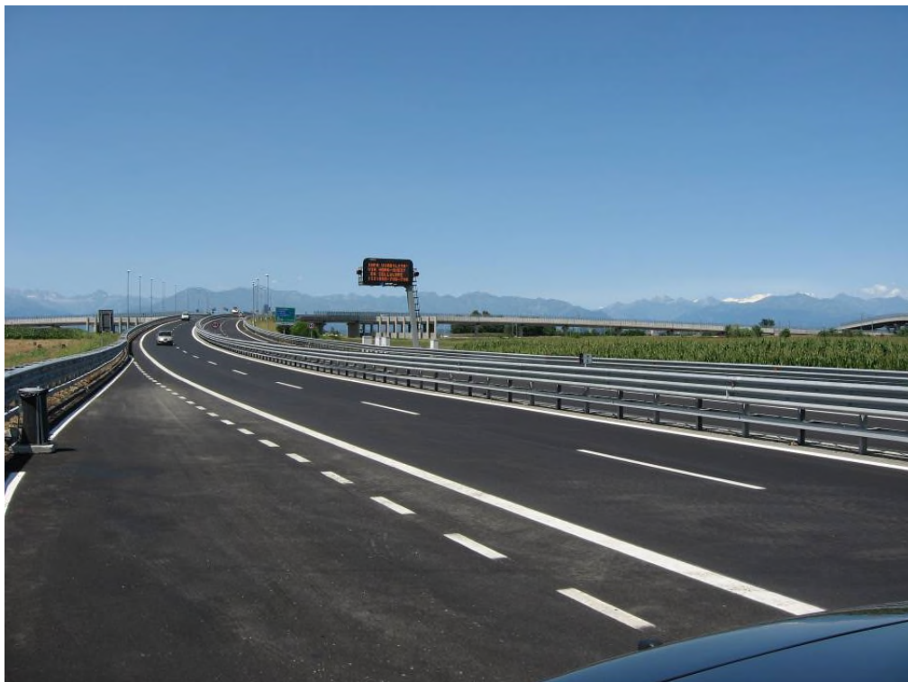
Tratto con barriera spartitraffico esistente di recente installazione
